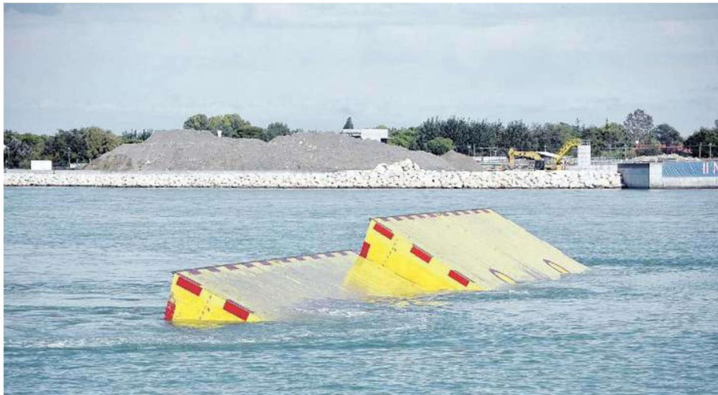
MOSE Le prime paratoie mobili si sollevano durante uno dei test effettuati nell'unico tratto completato, quello tra l'isola artificiale e Punta Sabbioni
