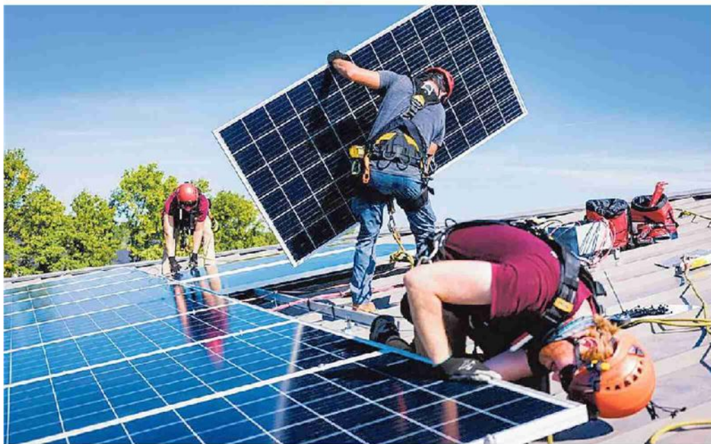
L'installazione di alcuni pannello fotovoltaici
